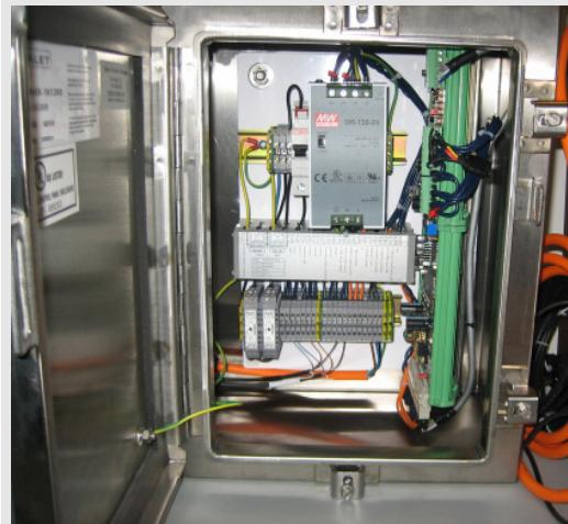
... im spritzwassergeschützten NEMA4 Schaltschrank, mit Netzverdrahtung, Sicherung, Netzteil und Optotrennrelais ...
